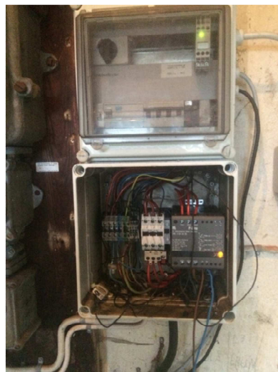
Gl. styretavle med nyere softstarter Som er dimensioneret for lille !
