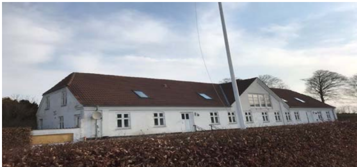
Stuehuset på Sønder Hestvang er opført i 1860.
